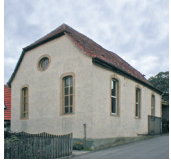
Rückansicht der ehemaligen Synagoge, 2015
